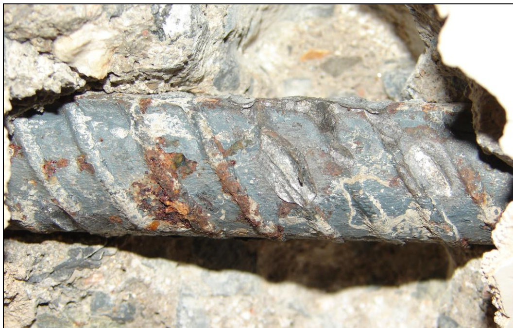
Foto 8: STROPNÍ PANEL P2, strop nad 1.NP; výztuž Ø 20 (10 400), výztuž je zasažena slabou povrchovou korozí bez tvorby korozních zplodin a bez zjevného úbytku plochy průřezu
