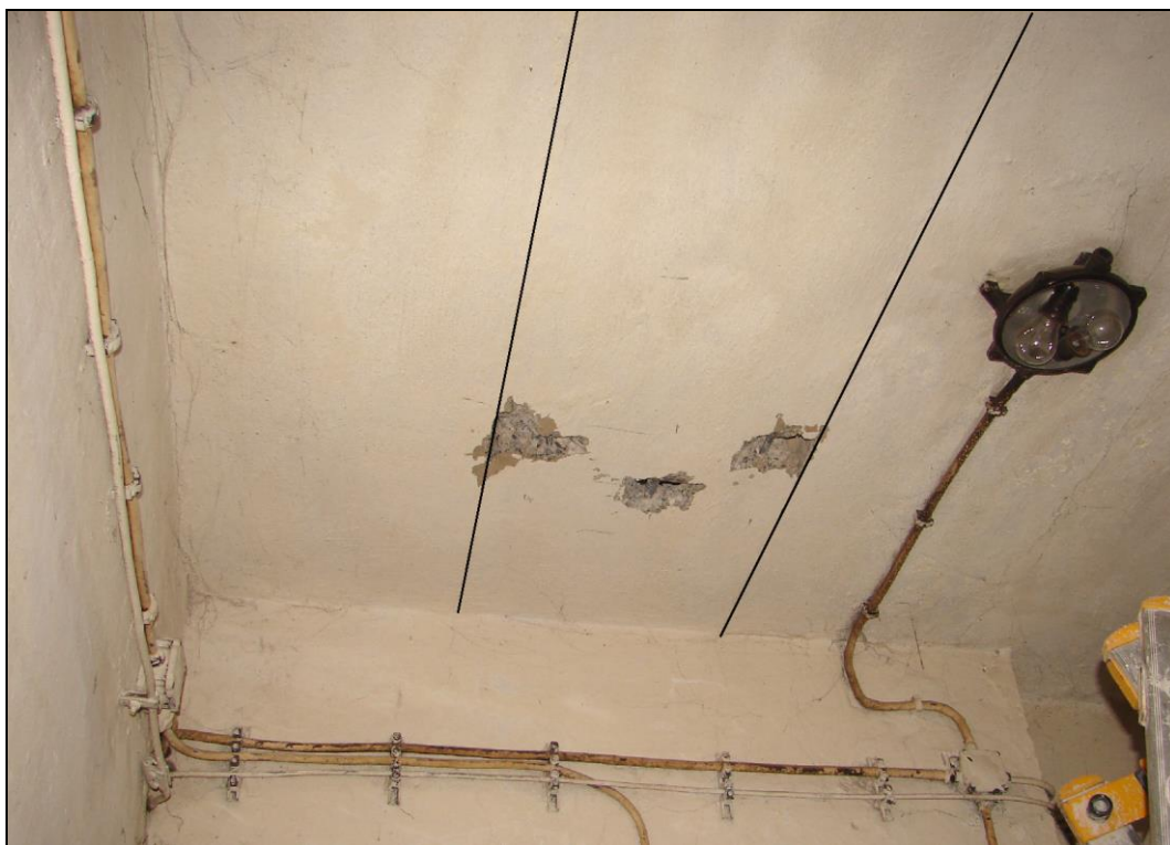
Foto 11: STROPNÍ PANEL P3, strop nad 1.PP; celkový pohled na sondu, černými čarami vyznačeny hrany panelu šířky 500 mm
