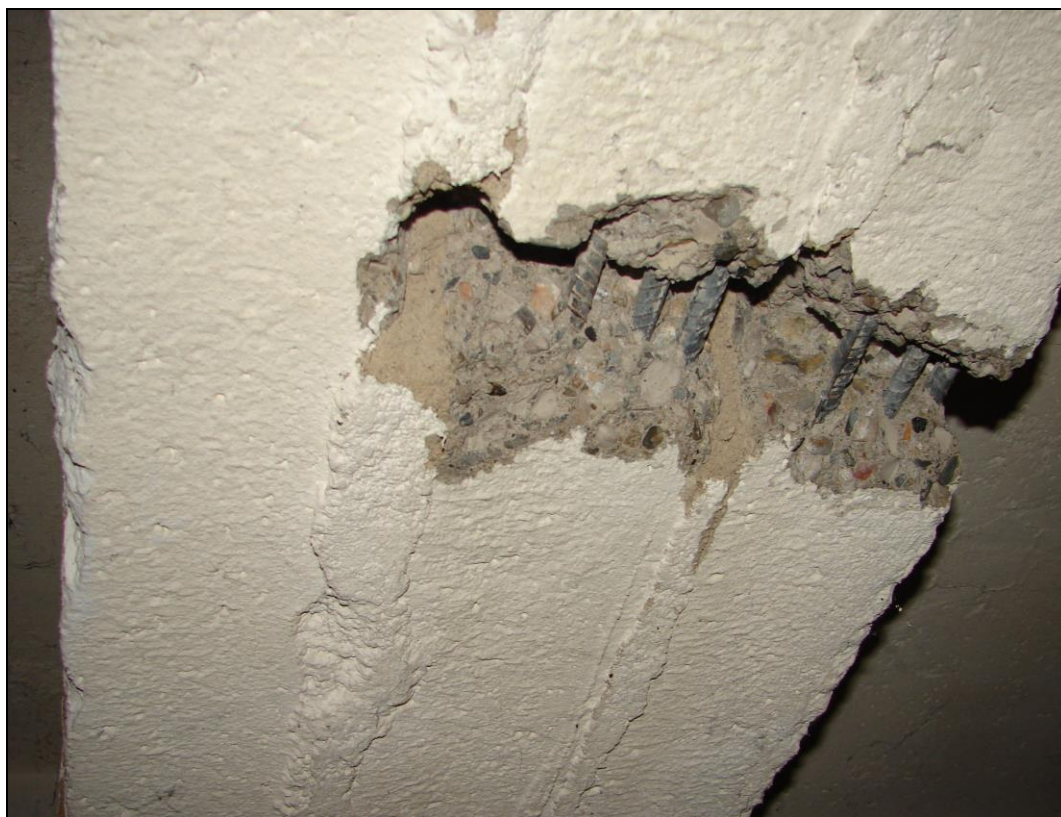
Foto 26: STROPNÍ PŘEKLAD P1, strop nad 1.PP; překlad sestává ze tří prefabrikátů, každý je vyztužen 3 Ø 10 (10 400)
