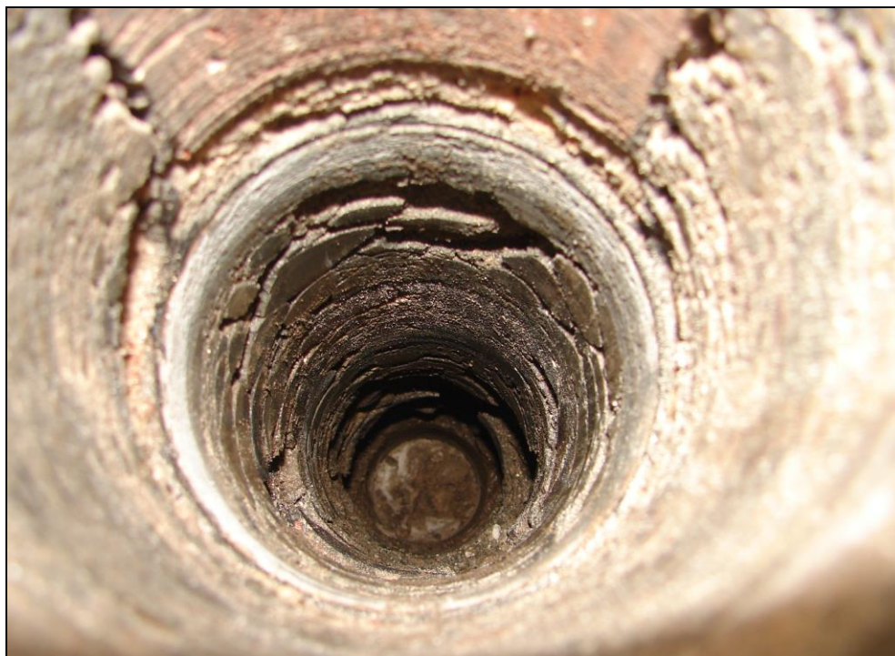
Foto 2: Základ Z1, 1.NP, novější přístavba; pohled do otvoru po ukončení jádrového vývrtu
