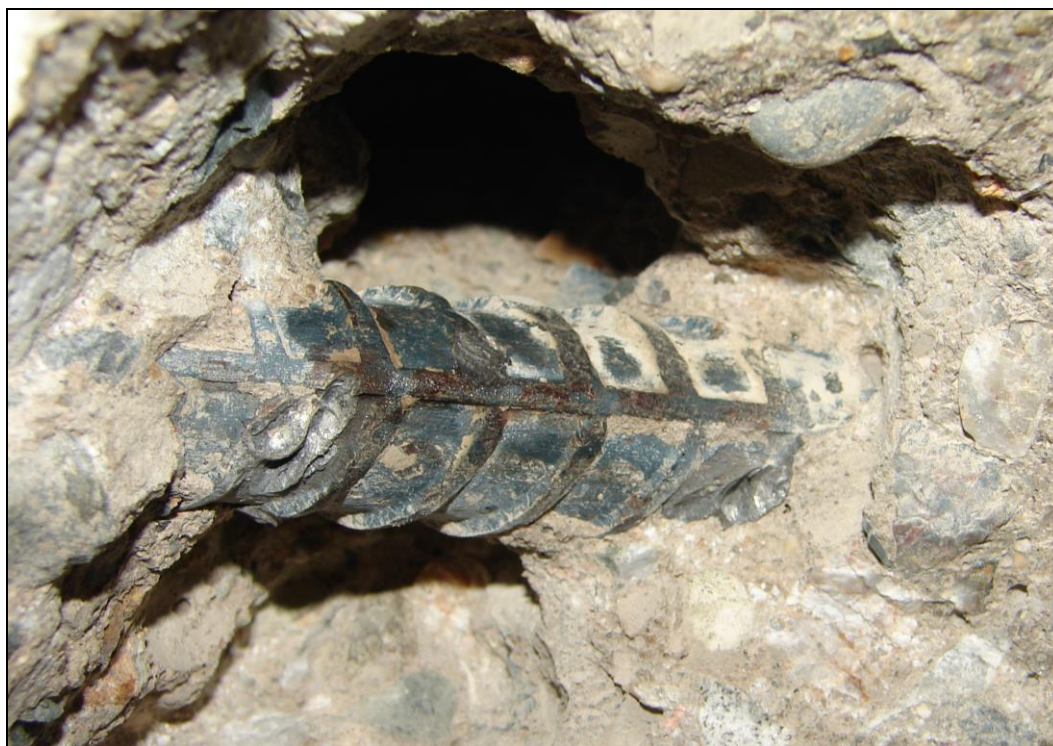
Foto 16: STROPNÍ PANEL P4, strop nad 1.PP; výztuž Ø 16 (10 400), výztuž je prakticky bez známek koroze
