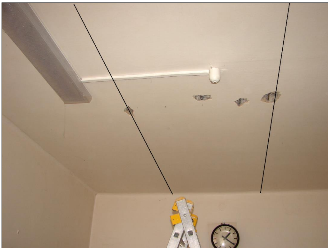
Foto 7: STROPNÍ PANEL P2, strop nad 1.NP; celkový pohled na sondu, černými čarami vyznačeny hrany panelu šířky 990 mm
