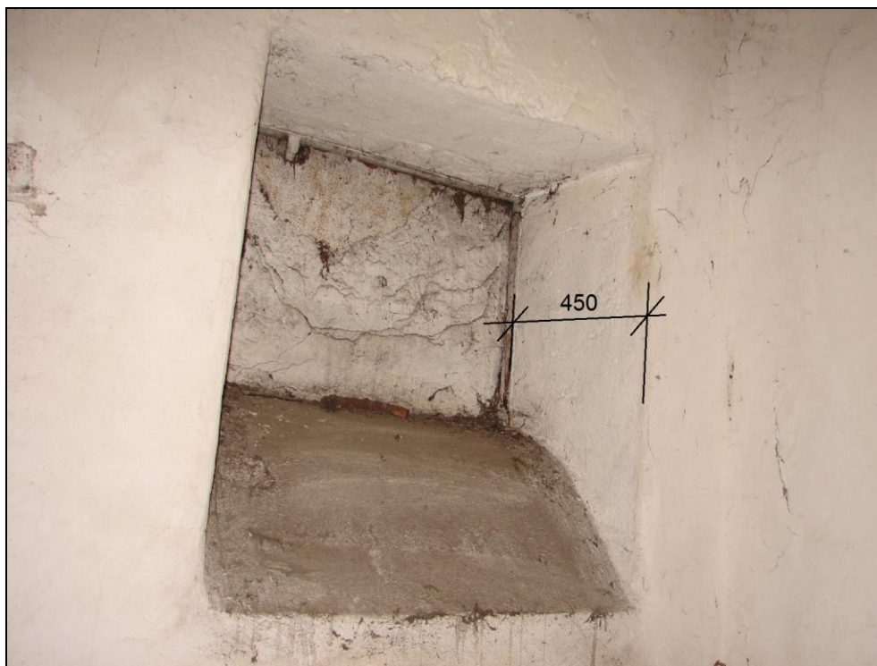
Foto 2: 1.PP, obvodová stěna směrem k ul. Vrážská; místo měření 1, tloušťka obvodové stěny 450 mm (v dokumentaci [1] není tl. stěny uvedena)
