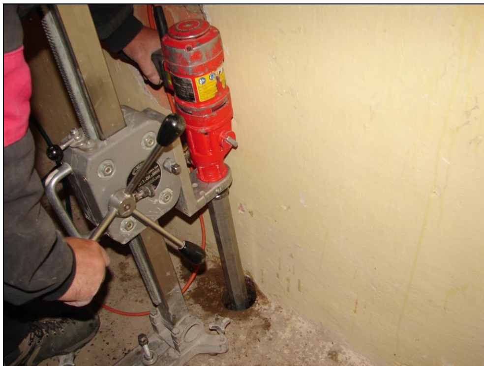
Foto 6: Základ Z2, 1.PP, starší přístavba; provádění jádrového vývrtu Ø 80 mm do základu
