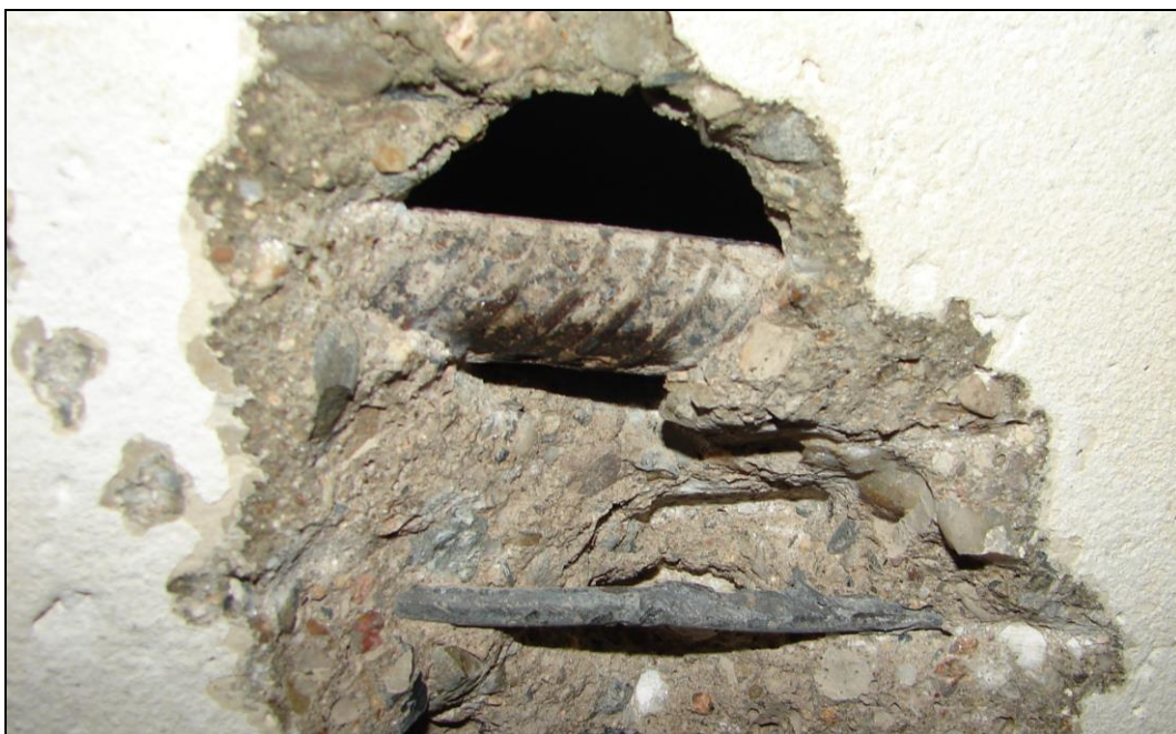
Foto 19: STROPNÍ PANEL P5, strop nad 1.PP; výztuž Ø 18 (10 400) a podélná výztuž Ø 5 (10 216), výztuž Ø 18 je zasažena povrchovou korozí bez tvorby korozních zplodin a bez zjevného úbytku plochy průřezu, Ø 5 je bez známek koroze
