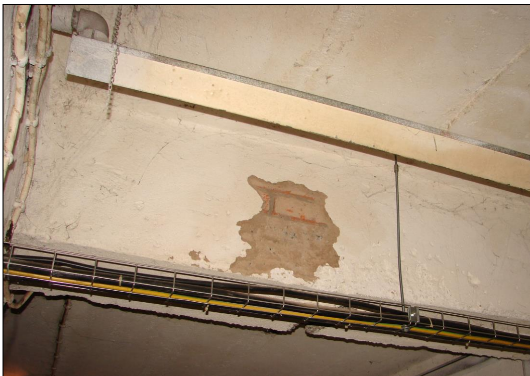
Foto 25: STROPNÍ PŘEKLAD P1, strop nad 1.PP; větší světlé výšky místnosti směrem k ulici bylo docíleno nazděním 3 řad cihel na překlád (detail z foto 23)
