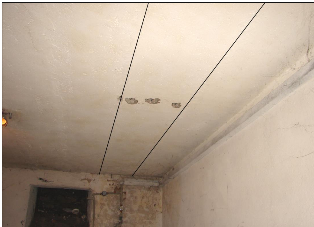
Foto 15: STROPNÍ PANEL P4, strop nad 1.PP; celkový pohled na sondu, černými čarami vyznačeny hrany panelu šířky 500 mm
