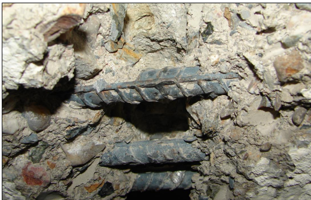
Foto 27: STROPNÍ PŘEKLAD P1, strop nad 1.PP; výztuž jednoho prefabrikátu 3 Ø 10 (10 400), výztuž je bez známek koroze
