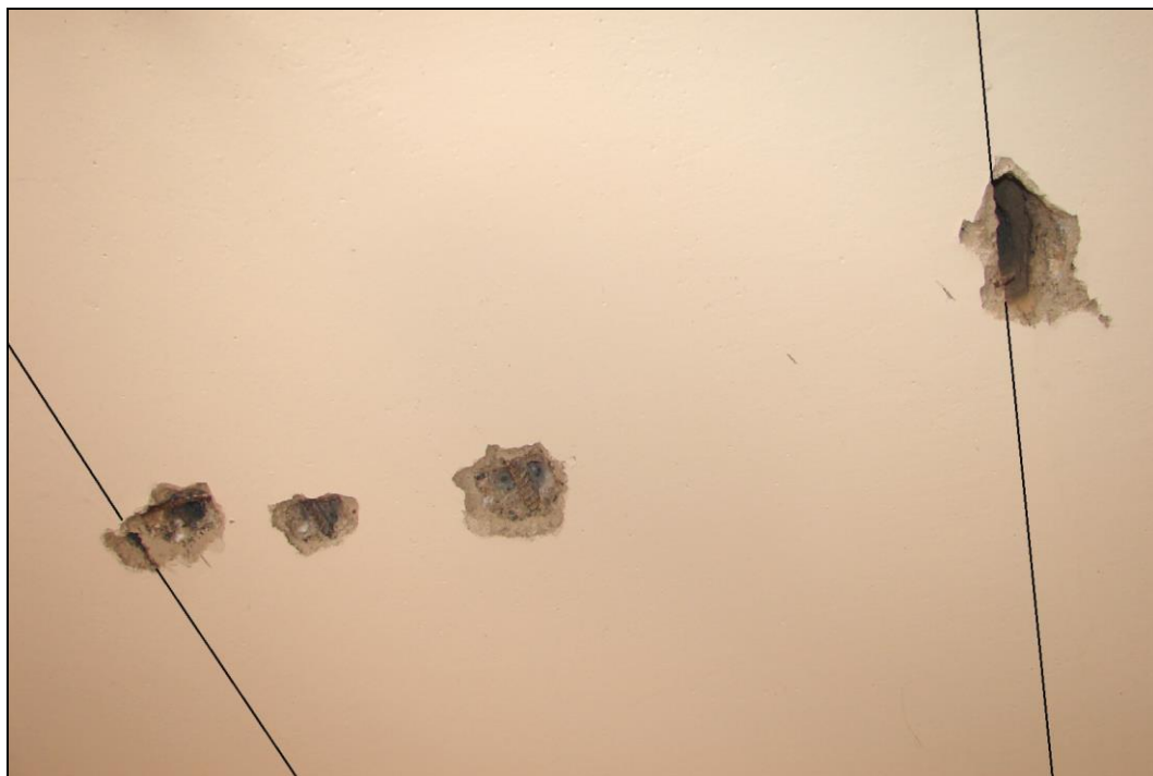
Foto 2: STROPNÍ PANEL P1, strop nad 1.NP; detailnější pohled na sondu, černě vyznačeny hrany panelu šířky 990 mm
