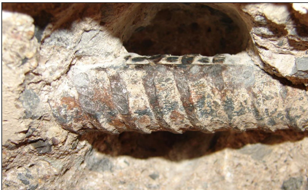
Foto 3: STROPNÍ PANEL P1, strop nad 1.NP; výztuž Ø 20 (10 400), výztuž je zasažena slabou povrchovou korozí bez tvorby korozních zplodin a bez zjevného úbytku plochy průřezu
