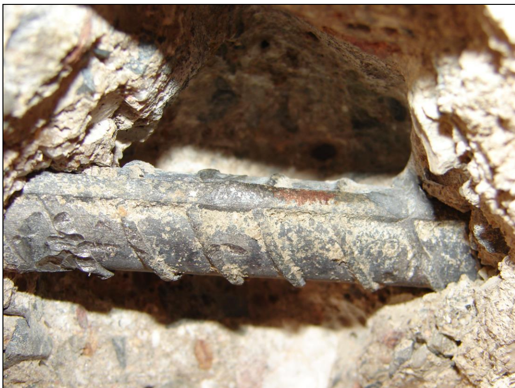
Foto 4: STROPNÍ PANEL P1, strop nad 1.NP; výztuž Ø 12 (10 400), výztuž je prakticky bez známek koroze
