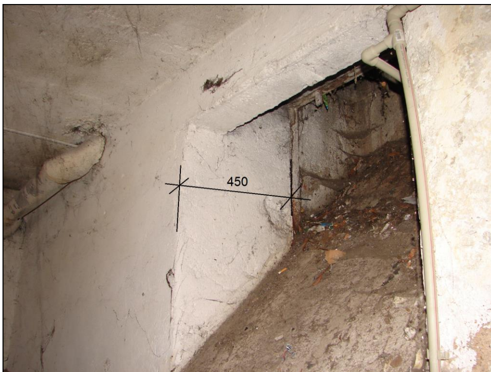
Foto 4: 1.PP, obvodová stěna směrem k trati; místo měření 2, tloušťka obvodové stěny 450 mm (v dokumentaci [1] uvedena tl. stěny 600 mm)
