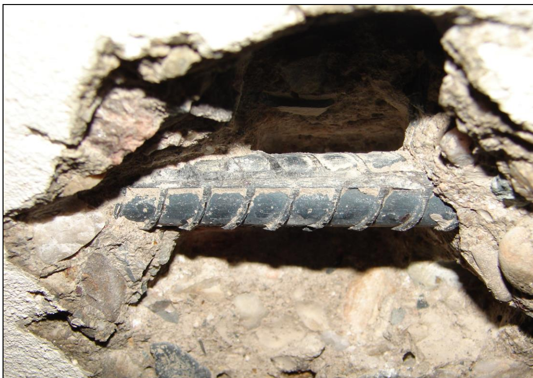
Foto 17: STROPNÍ PANEL P4, strop nad 1.PP; výztuž Ø 12 (10 400), výztuž je bez známek koroze
