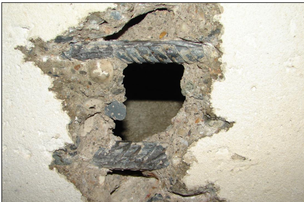
Foto 20: STROPNÍ PANEL P5, strop nad 1.PP; výztuž Ø 18 (10 400) a Ø 14 (10 400), výztuž je bez známek koroze
