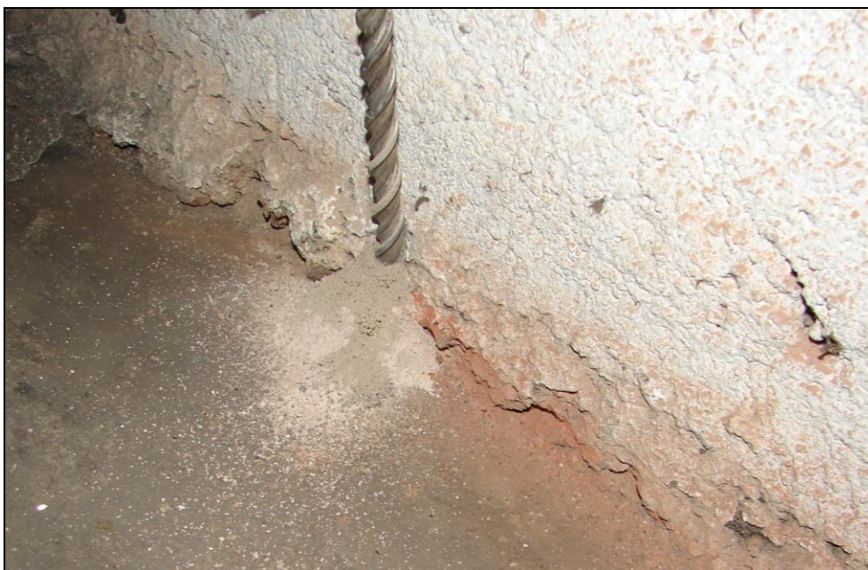
Foto 10: Základ Z3, 1.PP, starší přístavba; patrný je betonový prach vycházející z vrtu
