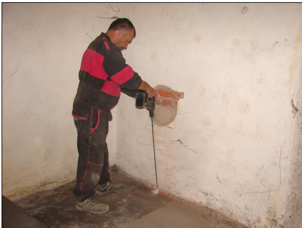
Foto 9: Základ Z3, 1.PP, starší přístavba; provádění vrtu Ø 10 mm do základu, materiál základu = beton (hl. vrtu cca 0,4 m)
