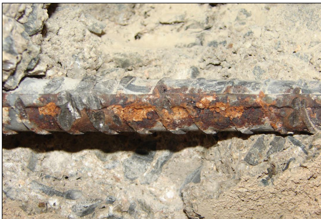
Foto 10: STROPNÍ PANEL P2, strop nad 1.NP; výztuž Ø 12 (10 400), výztuž je zasažena povrchovou korozí s počáteční tvorbou korozních zplodin avšak bez zjevného úbytku plochy průřezu
