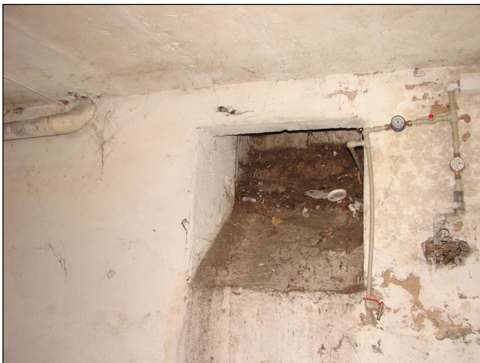
Foto 3: 1.PP, obvodová stěna směrem k trati; místo měření 2, otvor ve stěně v místě anglického dvorku, pro účely měření byla provedena prohlídka a ověření geometrie stěny i ze strany anglického dvorku (exteriéru)
