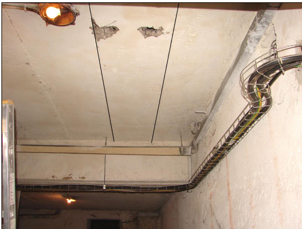
Foto 18: STROPNÍ PANEL P5, strop nad 1.PP; celkový pohled na sondu, černými čarami vyznačeny hrany panelu šířky 500 mm
