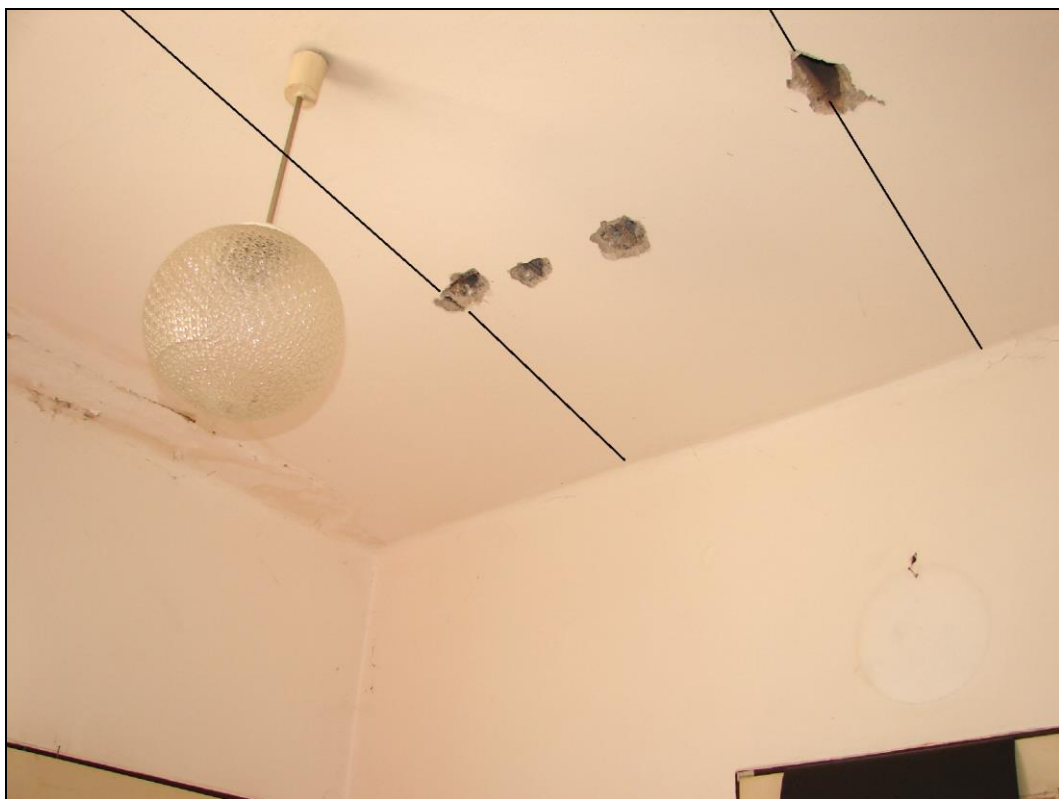
Foto 1: STROPNÍ PANEL P1, strop nad 1.NP; celkový pohled na sondu, černými čarami vyznačeny hrany panelu šířky 990 mm
