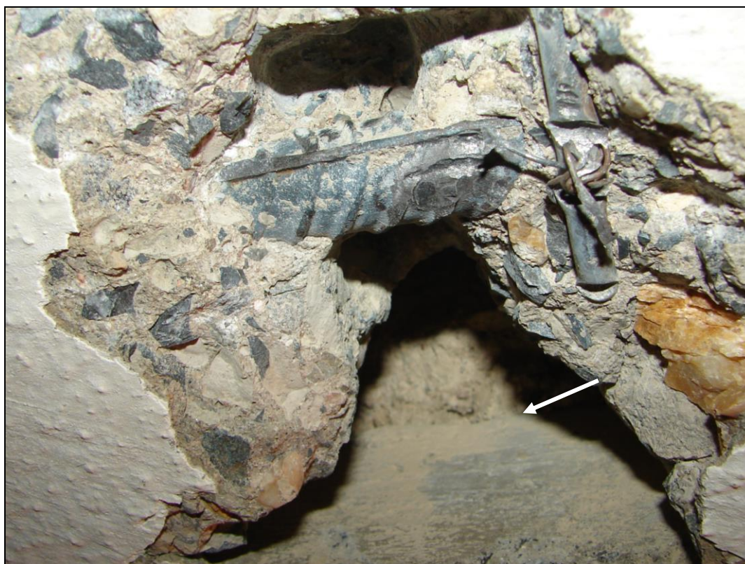
Foto 14: STROPNÍ PANEL P3, strop nad 1.PP; výztuž Ø 16 (10 400) a příčná výztuž Ø 5 (10 216), sonda do spáry pro zjištění výšky panelu (pohled nad boční líc), šipkou je vyznačena horní hrana sousedního panelu
