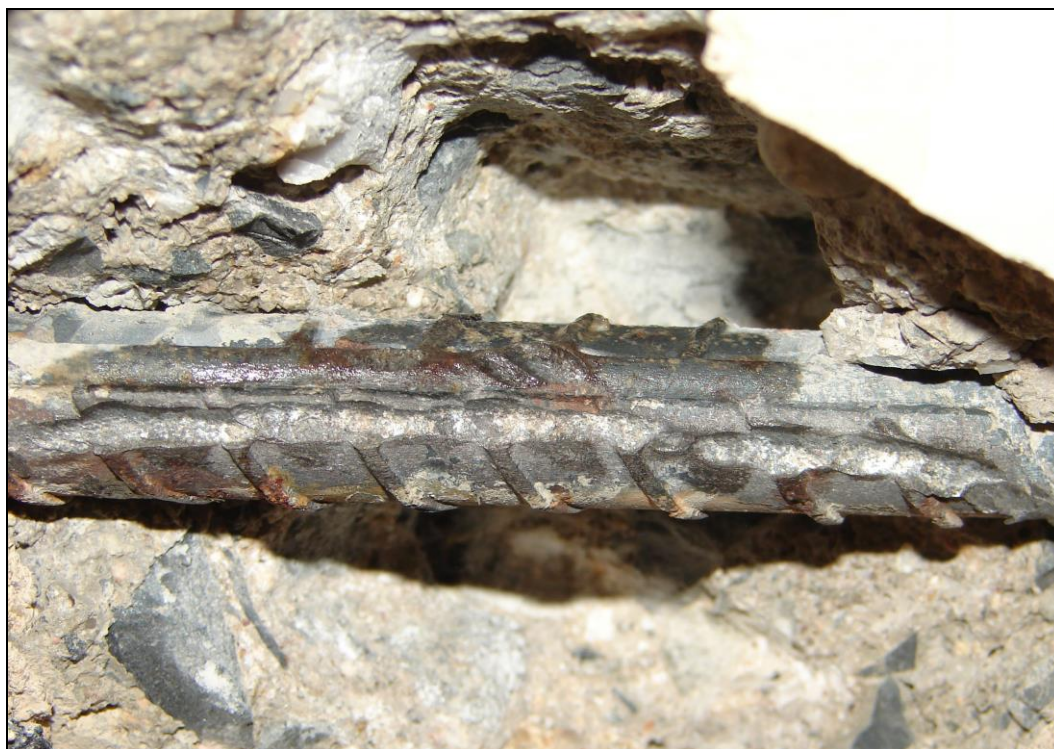
Foto 9: STROPNÍ PANEL P2, strop nad 1.NP; výztuž Ø 12 (10 400), výztuž je prakticky bez známek koroze
