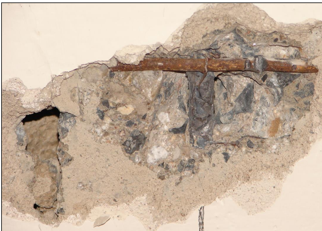
Foto 5: STROPNÍ PANEL P1, strop nad 1.NP; výztuž Ø 12 (10 400) a příčná výztuž Ø 5 (10 216), hlavní výztuž je bez známek koroze, příčná výztuž je zasažena povrchovou korozí bez tvorby korozních zplodin a bez zjevného úbytku plochy průřezu, vlevo je patrná hrana panelu
