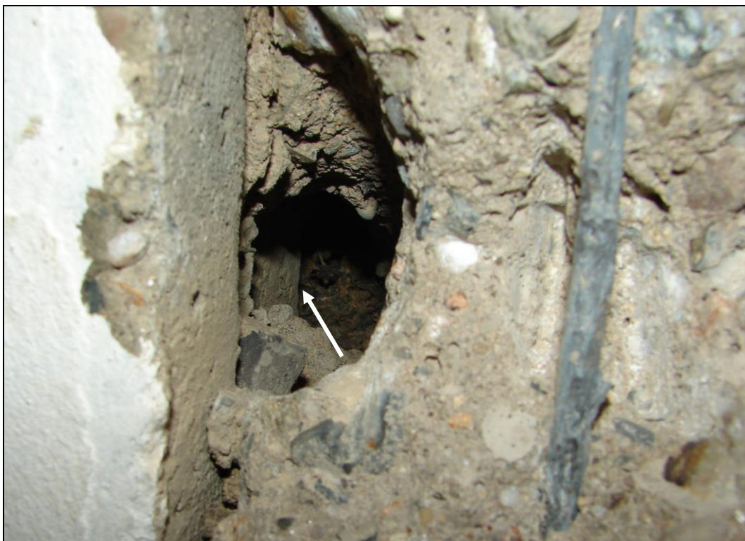
Foto 21: STROPNÍ PANEL P5, strop nad 1.PP; sonda do spáry pro zjištění výšky panelu (pohled nad boční líc), šipkou je vyznačena horní hrana sousedního panelu, patrna je i podélná výztuž Ø 5 (10 216)
