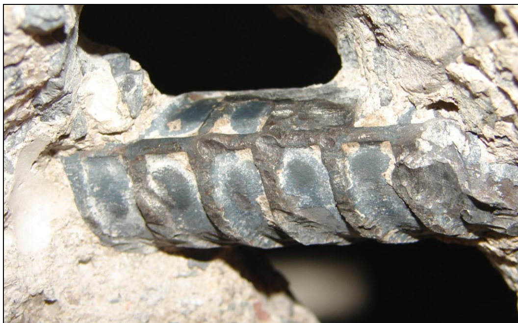
Foto 13: STROPNÍ PANEL P3, strop nad 1.PP; výztuž Ø 16 (10 400) výztuž je bez známek koroze
