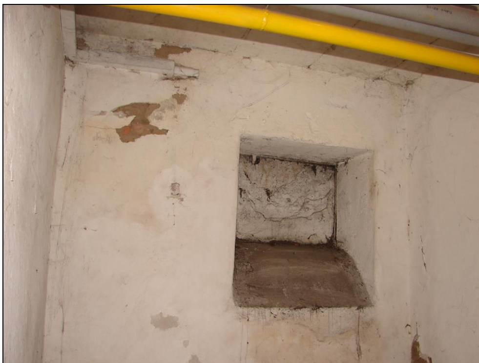
Foto 1: 1.PP, obvodová stěna směrem k ul. Vrážská; místo měření 1, otvor ve stěně v místě anglického dvorku, pro účely měření byla provedena prohlídka a ověření geometrie stěny i ze strany anglického dvorku (exteriéru)
