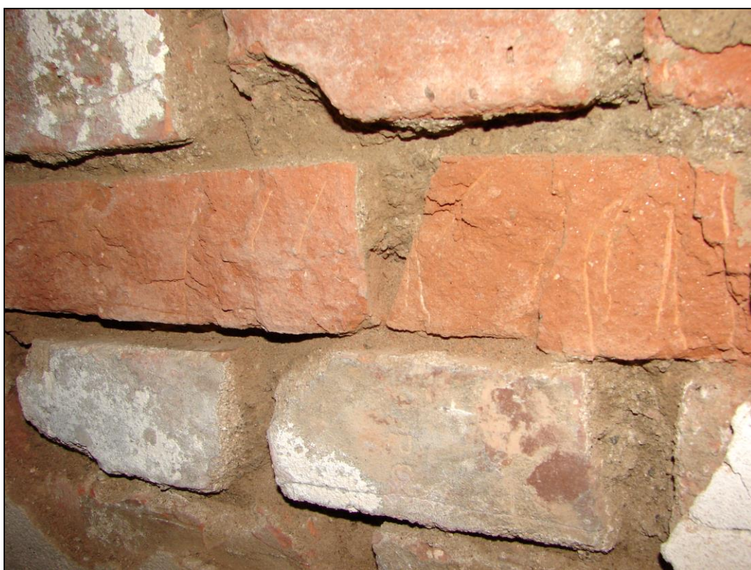
Foto 15: 1.PP, obvodová stěna, zk. místo Z11; degradace povrchových vrstev cihel v důsledku zasažení zdiva vlhkostí
