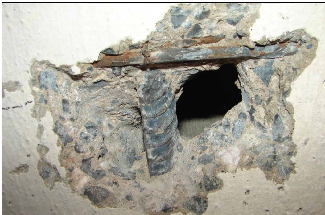
Foto 12: STROPNÍ PANEL P3, strop nad 1.PP; výztuž Ø 20 (10 400) a příčná výztuž Ø 5 (10 216), hlavní výztuž je bez známek koroze, příčná výztuž je zasažena povrchovou korozí bez tvorby korozních zplodin a bez zjevného úbytku plochy průřezu
